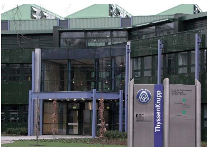
Facility of the Dortmunder OberflächenCentrum
